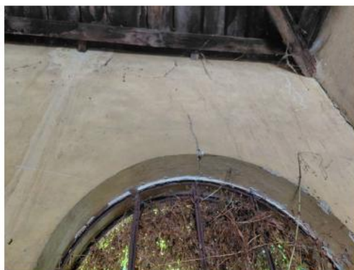
Lavatoio Piazzetta dei Fiori - Foto (14)
