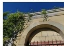
Lavatoio Piazzetta dei Fiori - Foto (4)
