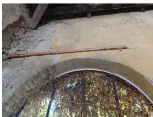
Lavatoio Piazzetta dei Fiori - Foto (12)
