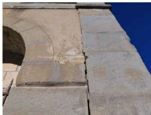
Lavatoio Piazzetta dei Fiori - Foto (2)
