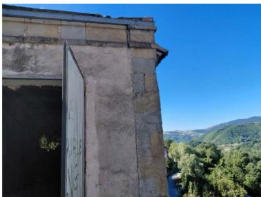
Lavatoio Piazzetta dei Fiori - Foto (21)
