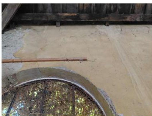
Lavatoio Piazzetta dei Fiori - Foto (11)
