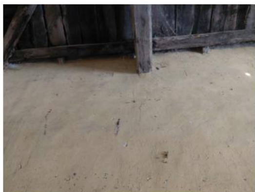
Lavatoio Piazzetta dei Fiori - Foto (17)
