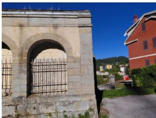
Lavatoio Piazzetta dei Fiori - Foto (1)
