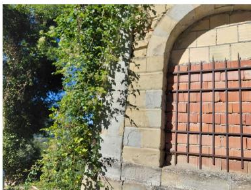
Lavatoio Piazzetta dei Fiori - Foto (5)
