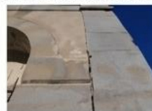
Lavatoio Piazzetta dei Fiori - Foto (2)
