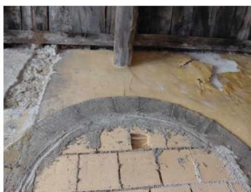
Lavatoio Piazzetta dei Fiori - Foto (8)
