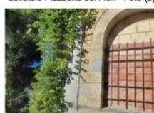
Lavatoio Piazzetta dei Fiori - Foto (5)
