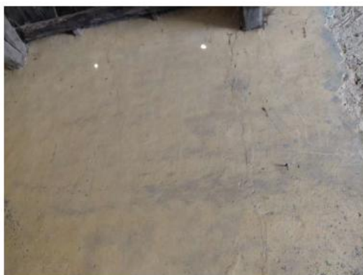
Lavatoio Piazzetta dei Fiori - Foto (18)
