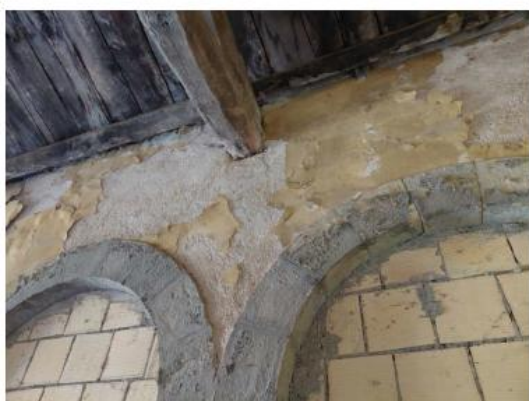
Lavatoio Piazzetta dei Fiori - Foto (9)
