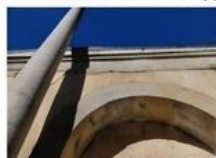
Lavatoio Piazzetta dei Fiori - Foto (3)
