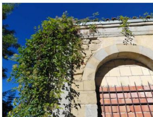
Lavatoio Piazzetta dei Fiori - Foto (6)
