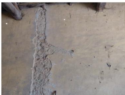
Lavatoio Piazzetta dei Fiori - Foto (20)
