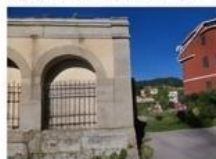
Lavatoio Piazzetta dei Fiori - Foto (1)
