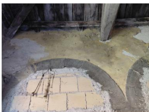
Lavatoio Piazzetta dei Fiori - Foto (7)
