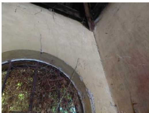
Lavatoio Piazzetta dei Fiori - Foto (13)
