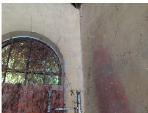
Lavatoio Piazzetta dei Fiori - Foto (15)
