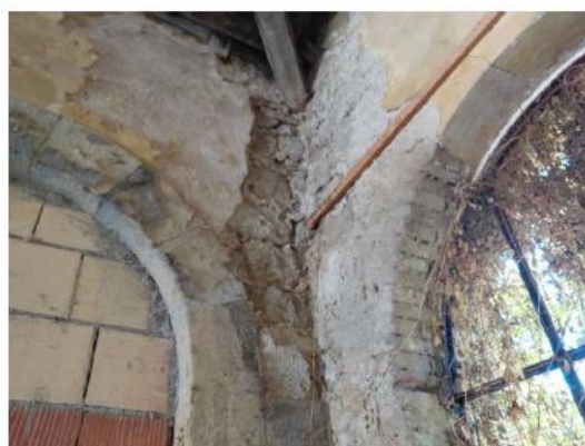
Lavatoio Piazzetta dei Fiori - Foto (10)
