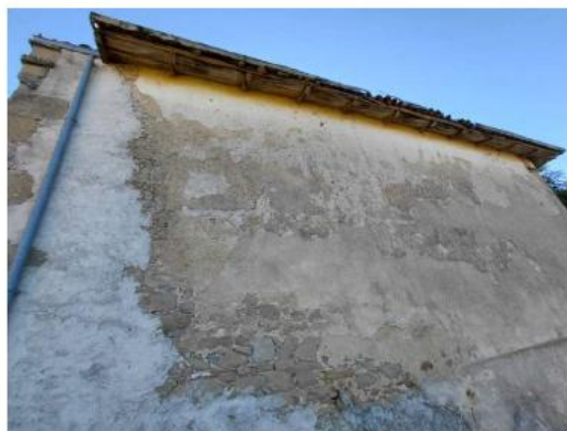
Lavatoio Piazzetta dei Fiori - Foto (22)
