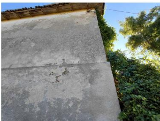
Lavatoio Piazzetta dei Fiori - Foto (23)
