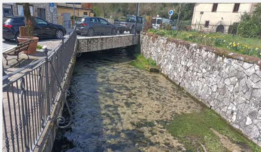
STATO DI FATTO DEL MURAGLIONE IN SPONDA SINISTRA DEL TORRENTE SCARZITO PRESSO LA SCUOLA DEL CAPOLUOGO
