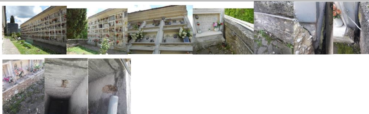
Lato cimitero vecchio
