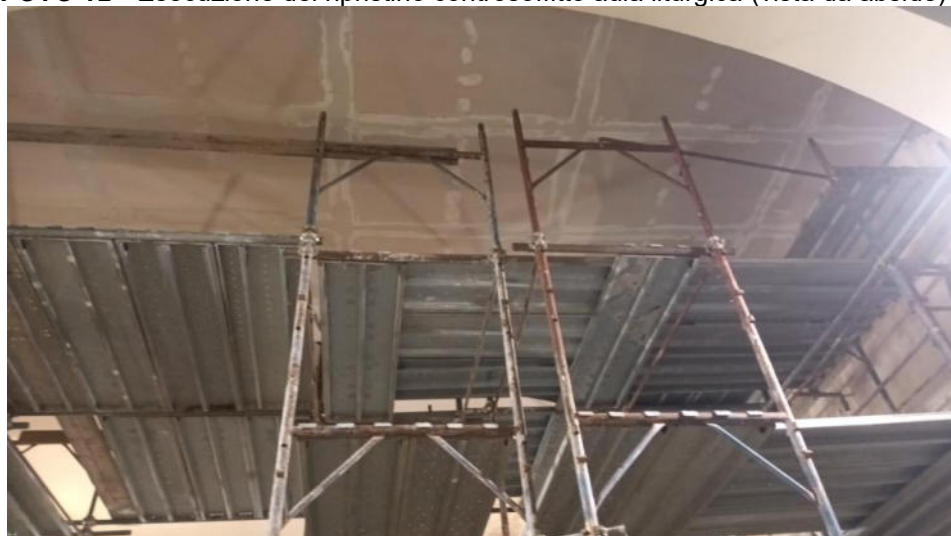
FOTO 12 - Esecuzione del ripristino controsoffitto aula liturgica (vista da abside)
