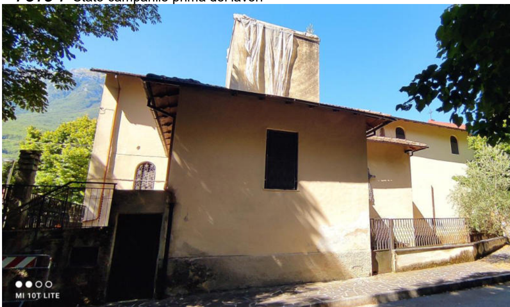
FOTO 1- Stato campanile prima dei lavori
