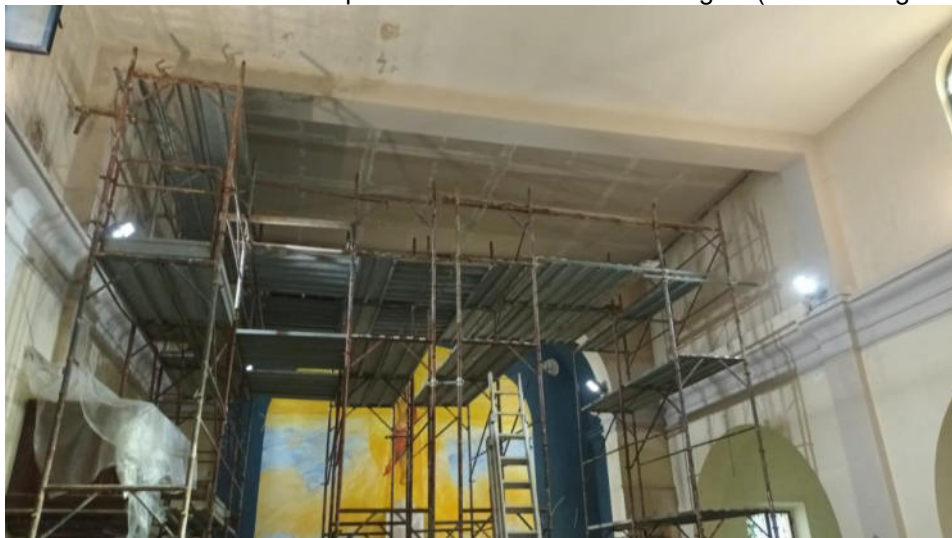
FOTO 11 - Esecuzione del ripristino controsoffitto aula liturgica (vista dall'ingresso)
