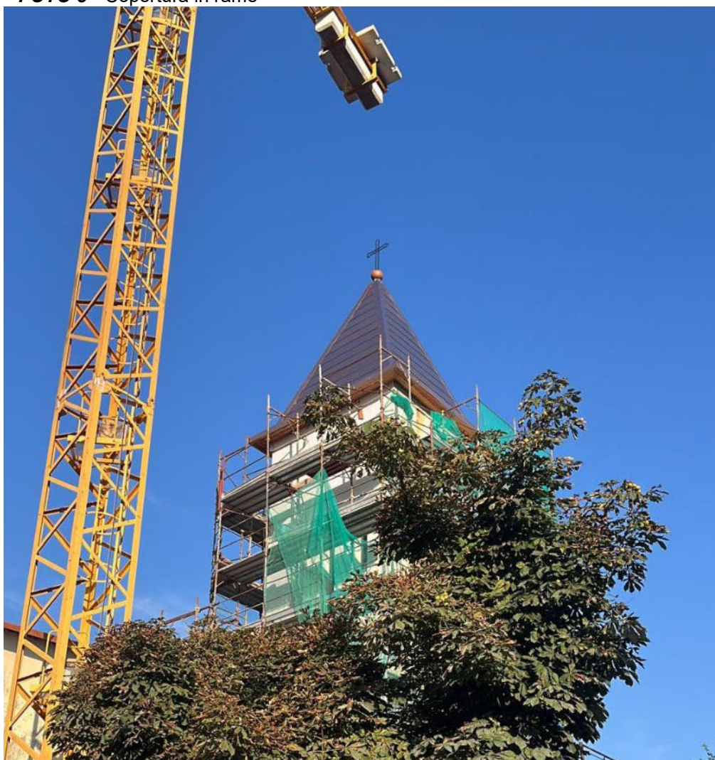
FOTO 8- Copertura in rame
