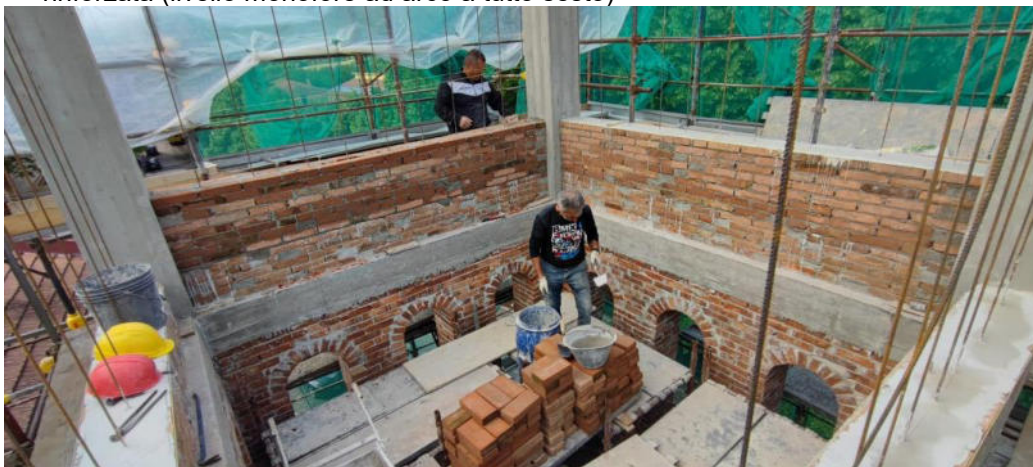
FOTO 4 - Ricostruzione della struttura mista in c.a e del 1° livello della muratura rinforzata (livello monofore ad arco a tutto sesto)
