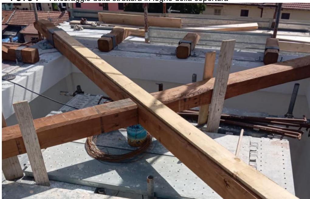
FOTO 7 - Ancoraggio della struttura in legno della copertura
