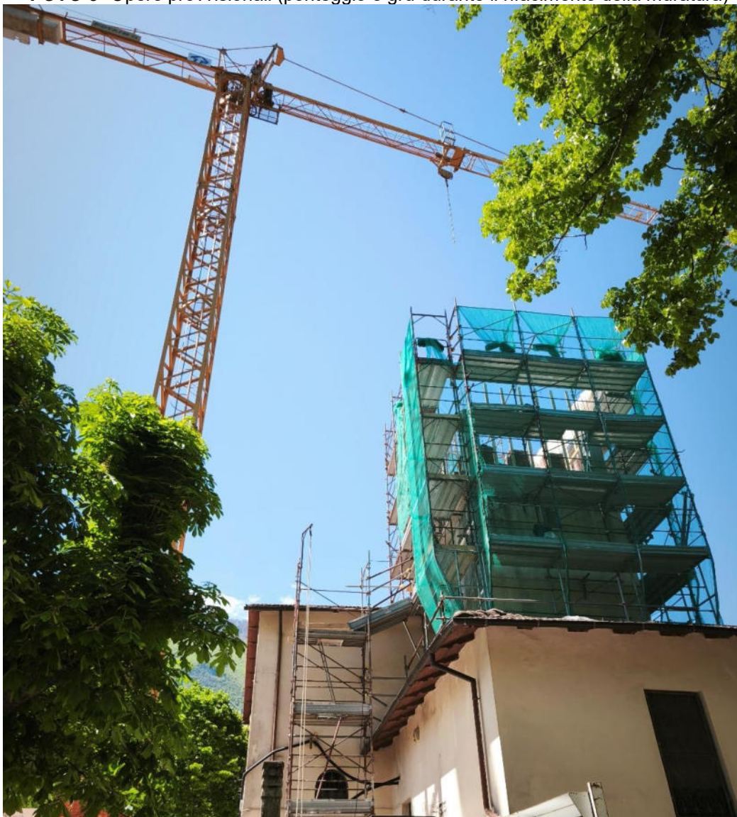
FOTO 3- Opere provvisorie (ponteggio e gru durante il rifacimento della muratura)
