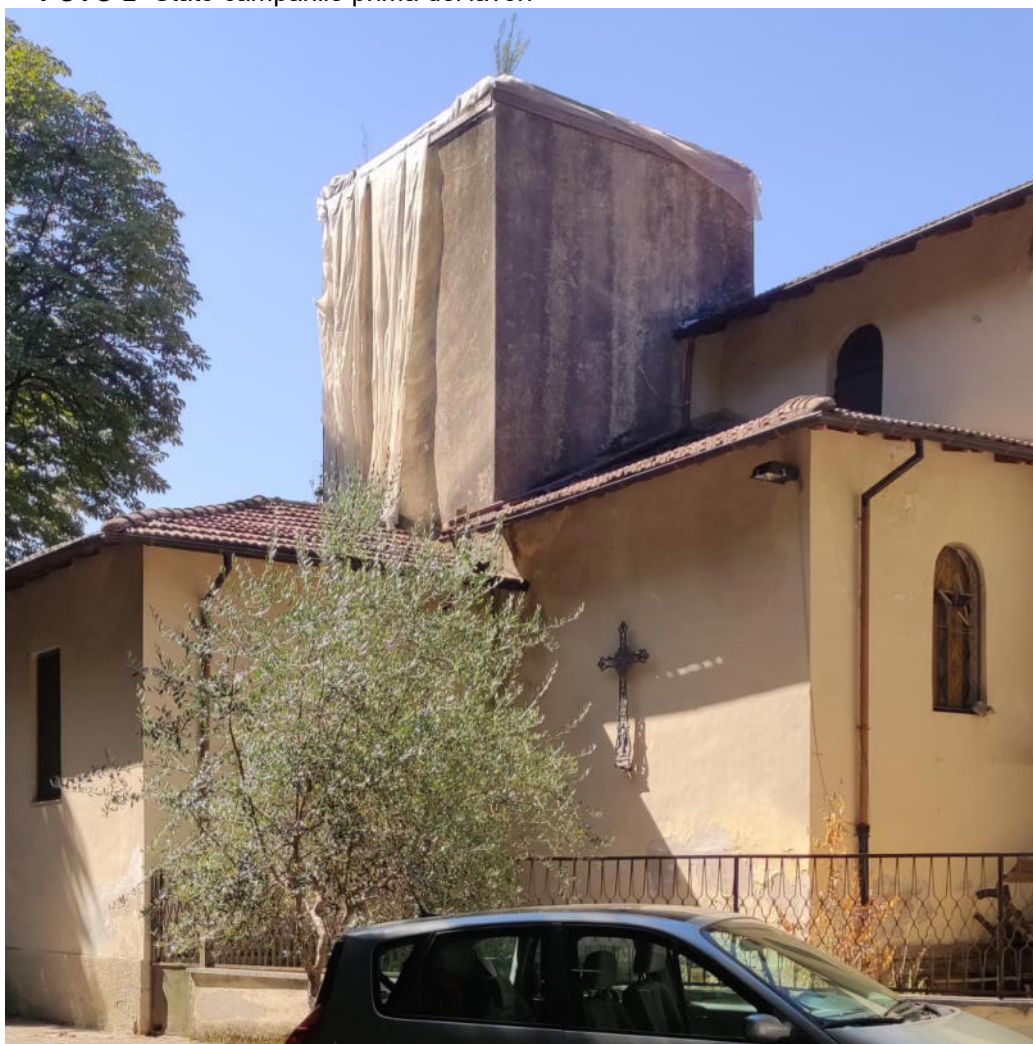
FOTO 2- Stato campanile prima dei lavori
