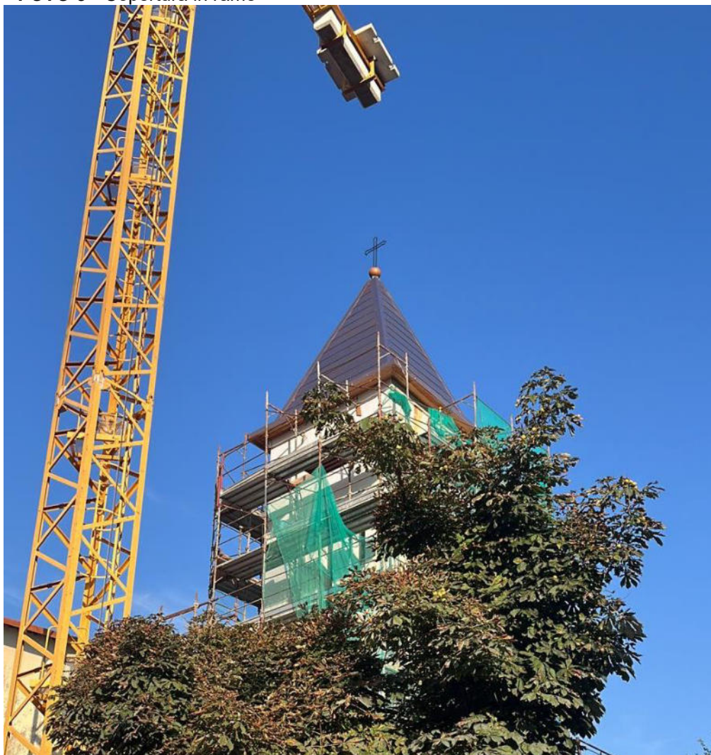
FOTO 8- Copertura in rame
