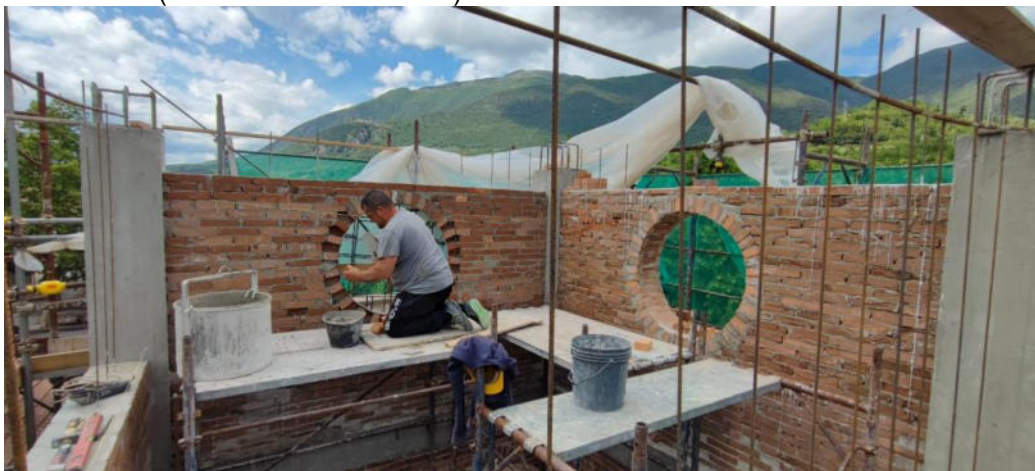
FOTO 6 - Posizionamento della dima per l'ancoraggio della struttura in legno della copertura del campanile prima del getto del cordolo di coronamento in c.a.
