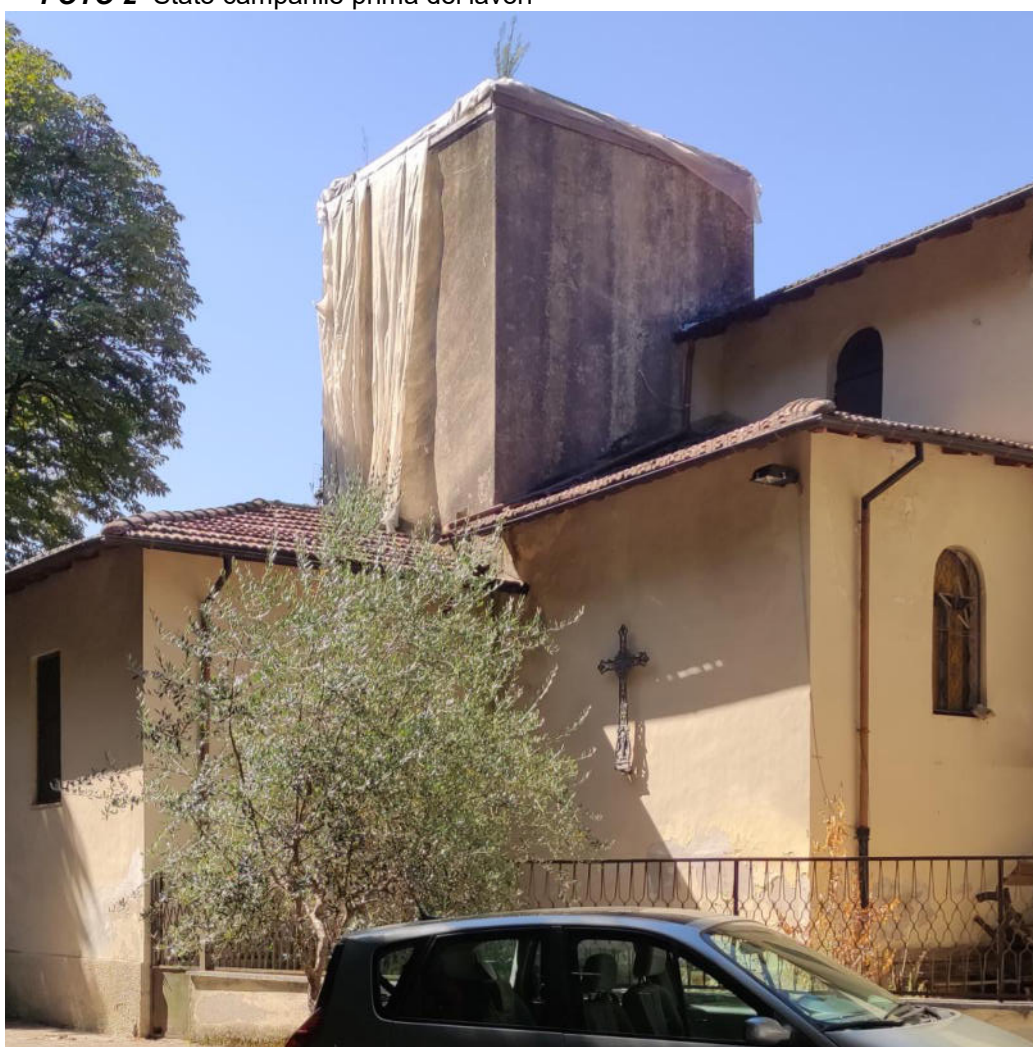
FOTO 2- Stato campanile prima dei lavori
