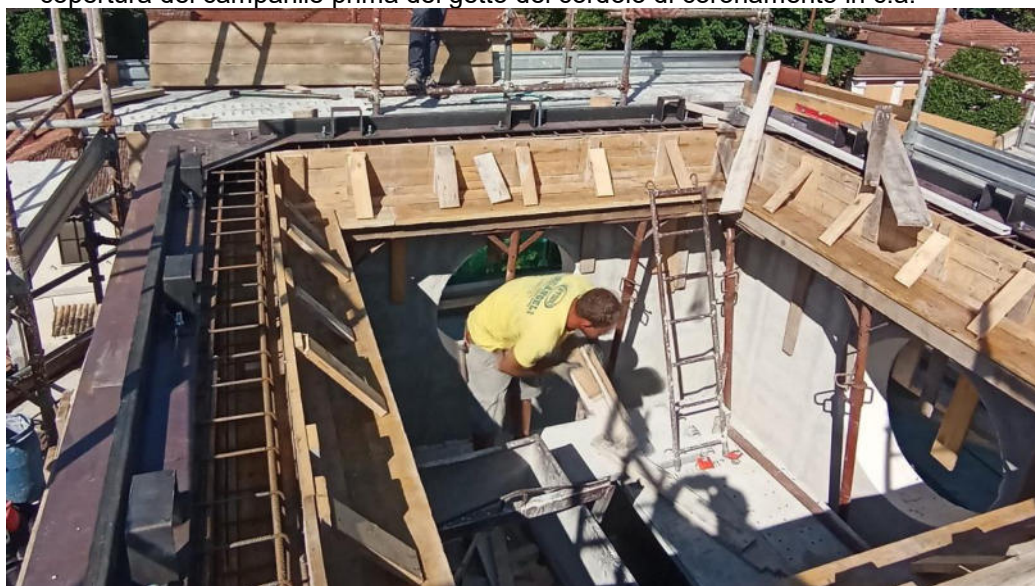
FOTO 7 - Ancoraggio della struttura in legno della copertura
