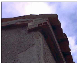
② Concrezione realizzata in mattoni frati
