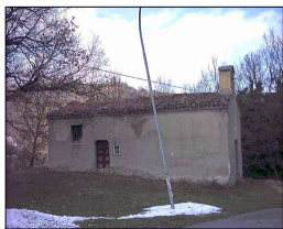
① Assenza di manutenzione, tamponata in epoche precedenti, a frattura dell'interno delle pareti esterne. Si nota inoltre la mancanza del cordolo perimetrale di fondazione in CA.
