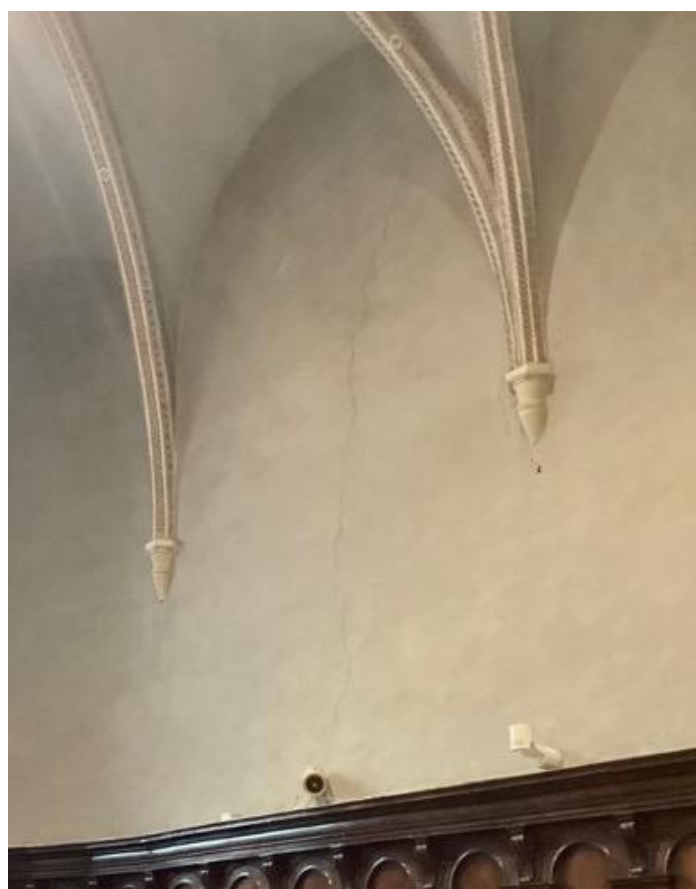
Figura 3: una lesione verticale nell'abside
