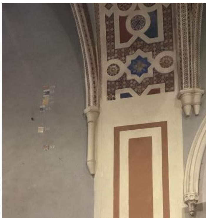
Figura 2: saggi stratigrafici precedenti ancora visibili evidenziano la presenza di superfici storiche decorate
