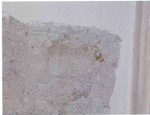
Perforo armato con barra di composito e resina epossidica
