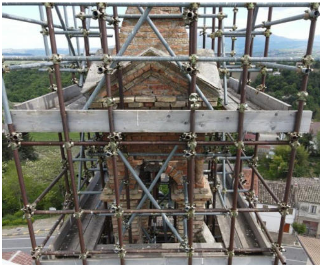
Foto della messa in sicurezza realizzata sulla torre campanaria oggetto di istruttoria
