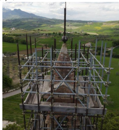
Foto della messa in sicurezza realizzata sulla torre campanaria oggetto di istruttoria
