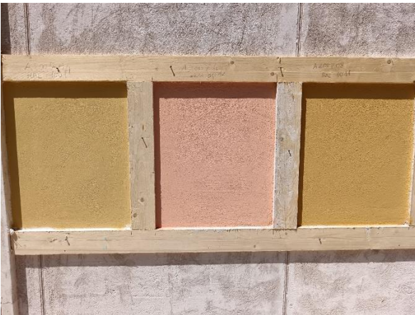
Interventi su facciata lato est e prove campionatura RAL con Soprintendenza
