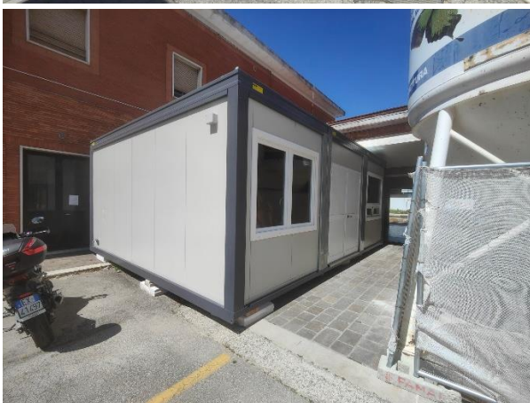
Posa in opera di n.2 shelter per Biglietteria e Polferr
