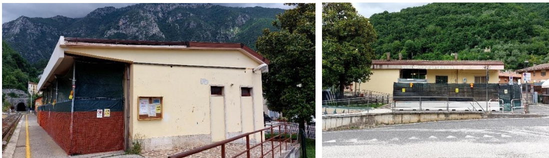
Lavori di manutenzione sulla facciata nel marciapiede I e lato piazzale
