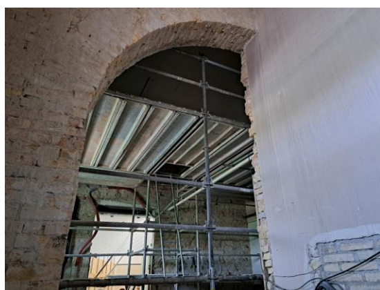
Messa a nudo delle murature al PT
