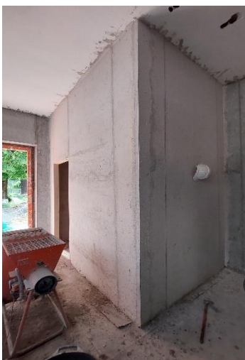
Realizzazione servizi igienici al PT
