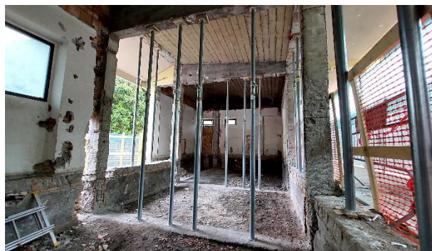
Rinforzo strutturale dei pilastri e della trave di copertura Intervento sulla fondazione
