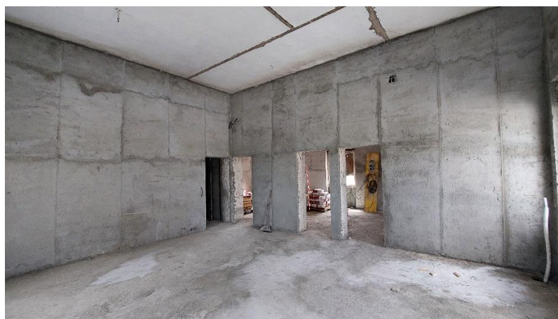
Interventi di rinforzo delle murature con intonaco armato nei locali del P1
