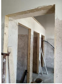
Interventi di rinforzo con intonaco armato e riqualifica wc piano terra
