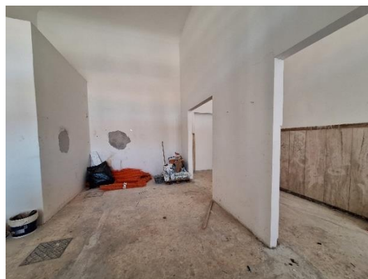
Messa a nudo delle murature del piano primo
