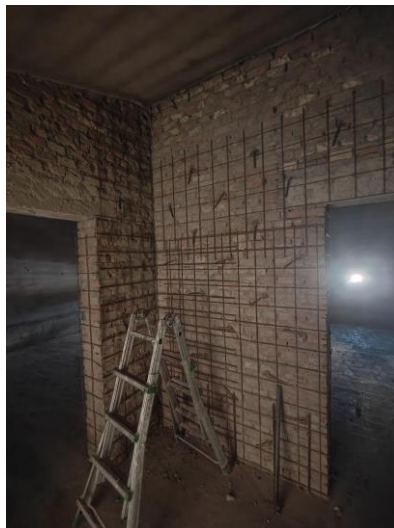
Intonaco armato in fase di esecuzione
