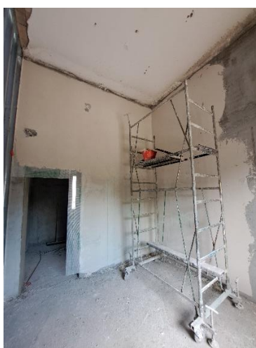
Interventi di rinforzo delle murature con intonaco armato nei locali del P1
