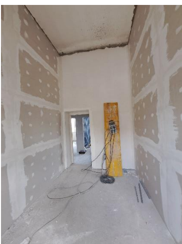
Realizzazione di tramezzature nei locali al P1
