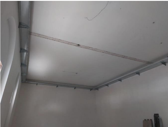
Rinforzo copertura e locale sottotetto
