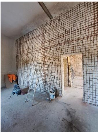
Interventi di rinforzo delle murature con intonaco armato nei locali del P1
