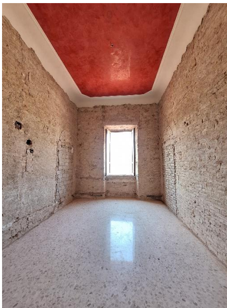
Messa a nudo delle murature del piano primo
