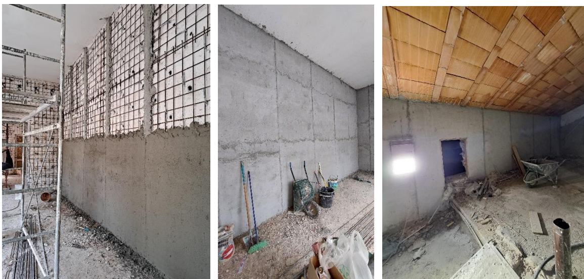
Interventi di rinforzo delle murature con intonaco armato nei locali del PT e sottotetto
