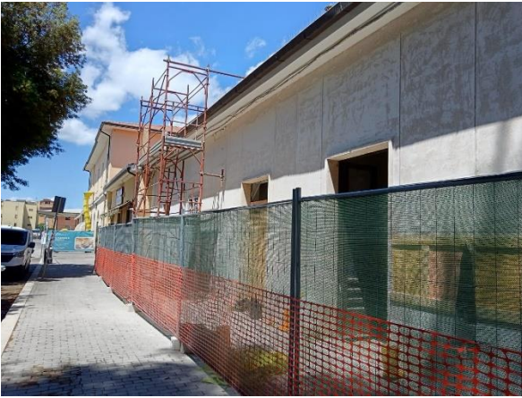
Interventi di rinforzo con intonaco armato e riqualifica wc piano terra
