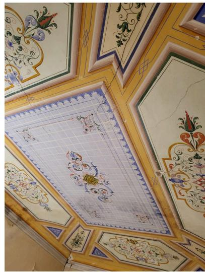
*Foto. 3 - Dettaglio fotografico di una camorcanna affrescata con lesioni da sisma.*
