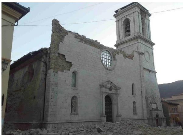
Facciata principale su piazza Duomo
