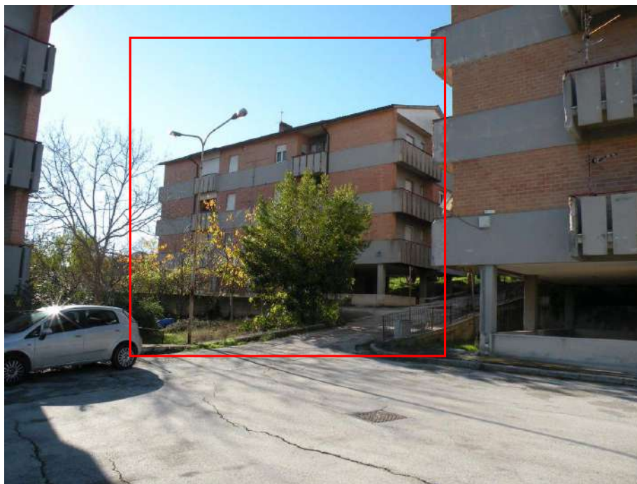
FOTO 5 - PALAZZINA "A". VISTA ANTERIORE
