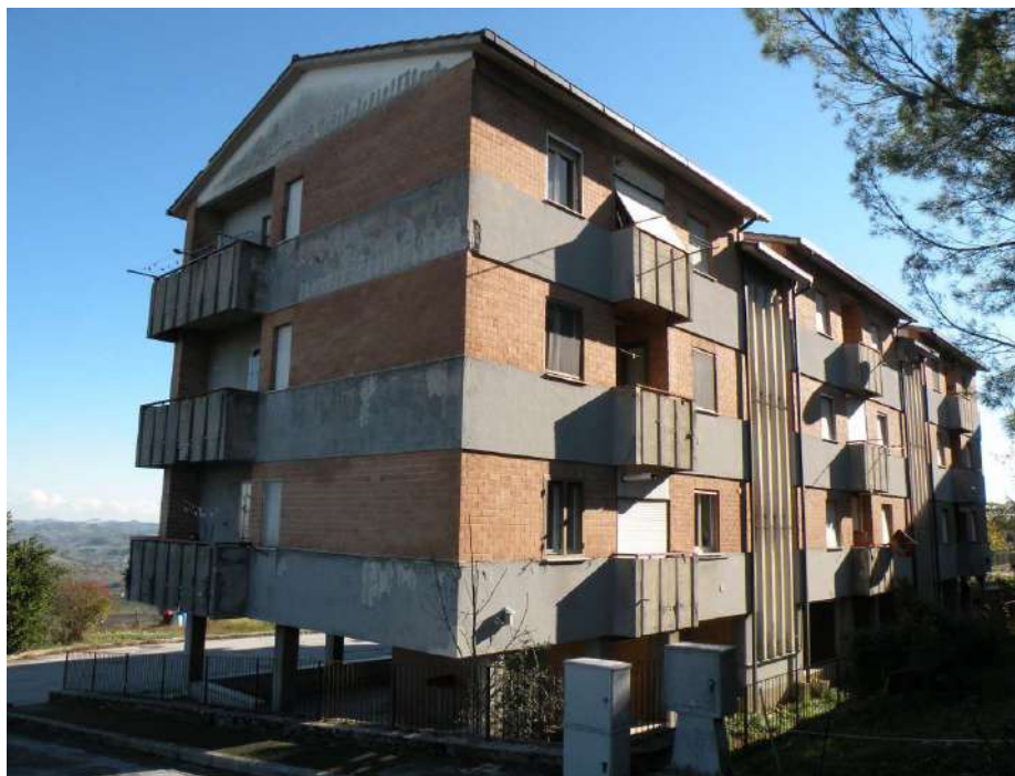
FOTO 8 – PALAZZINA “C”. VISTA POSTERIORE
