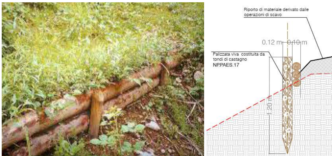
Figura 21 - esempio costruttivo di palizzata in legname
