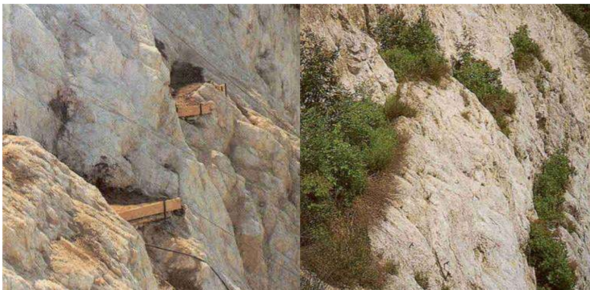
Figura 20 - esempio di costruzione di tasche vegetate in pareti rocciose
