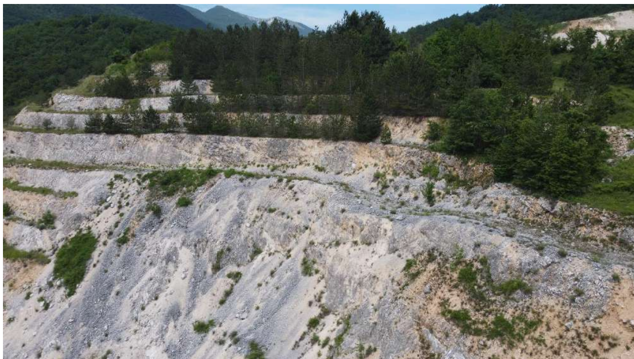
Figura 19 - tratto di versante in cui si sono verificati i movimenti franosi superficiali
