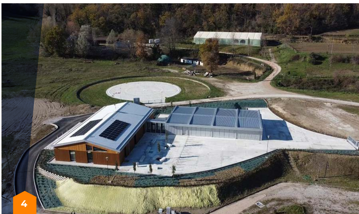
Costruzione del Centro polifunzionale di Protezione Civile a Comunanza (AP)
