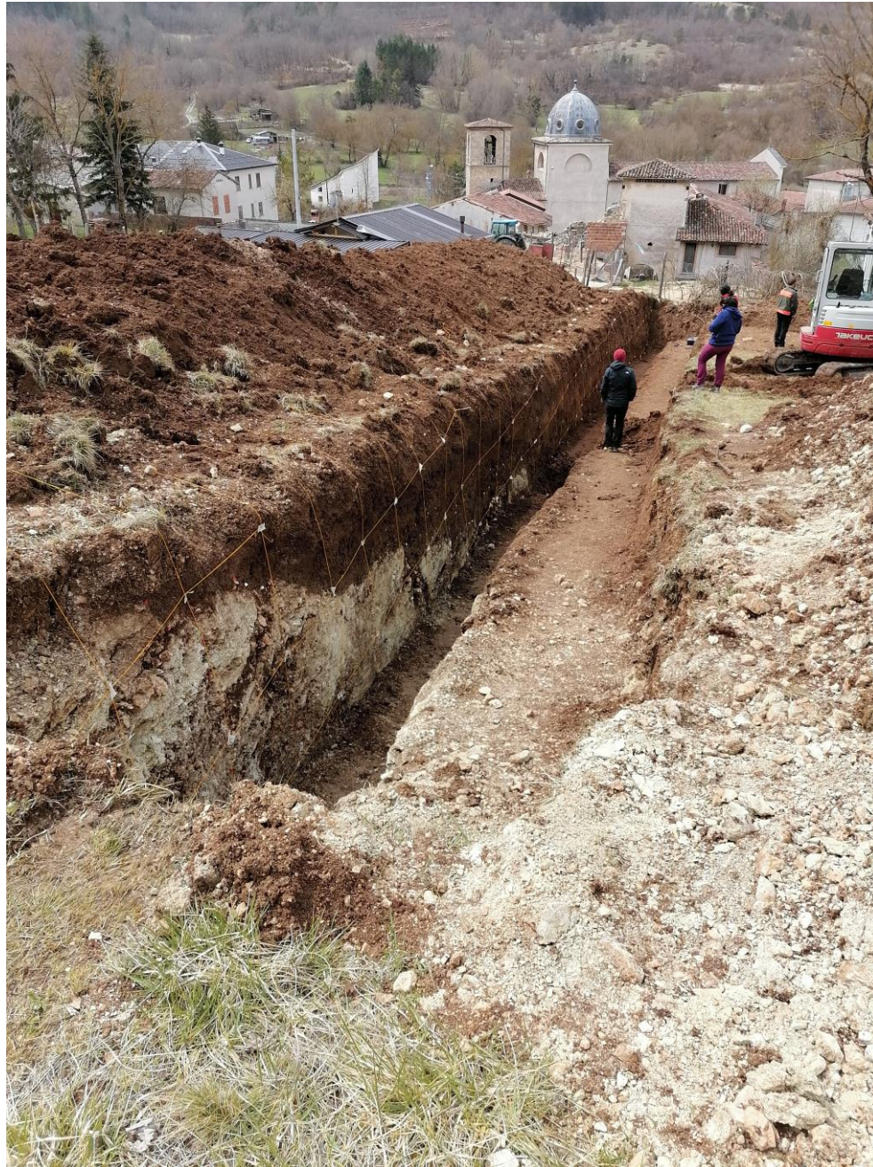
Figura 4 – Panoramica della trincea (per una sua ubicazione vedere figure 1 e 2).
