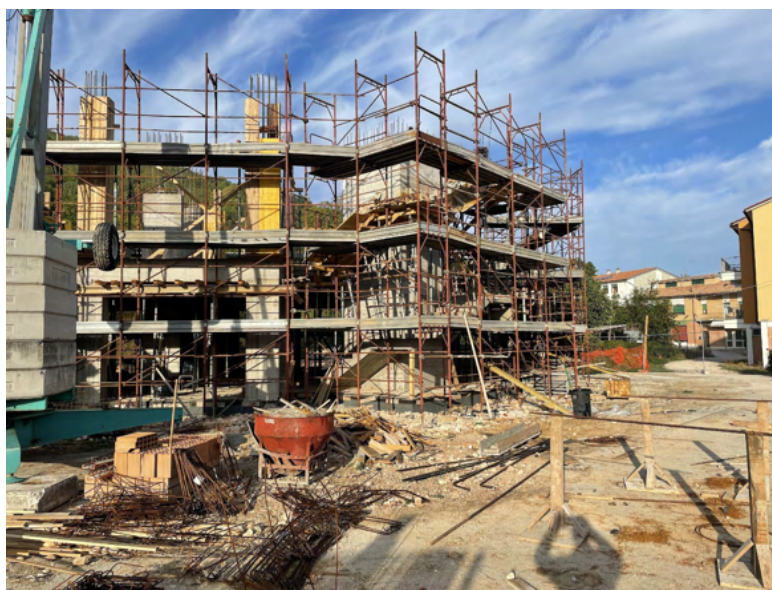
Struttura sede degli uffici comunali e del C.O.C. in corso di realizzazione
