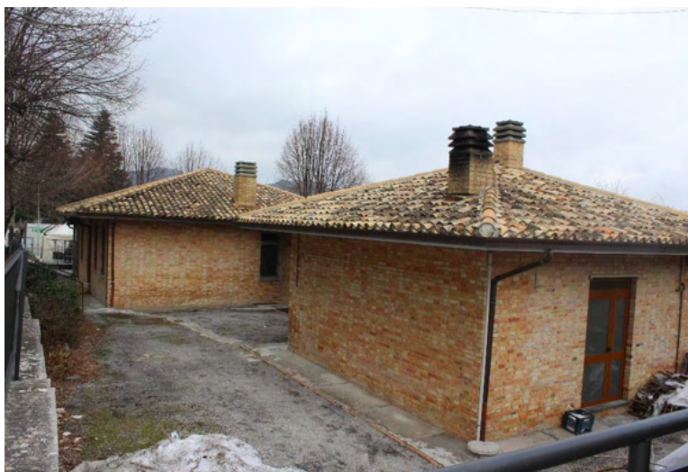
Il vecchio edificio esistente destinato ad attività commerciali
