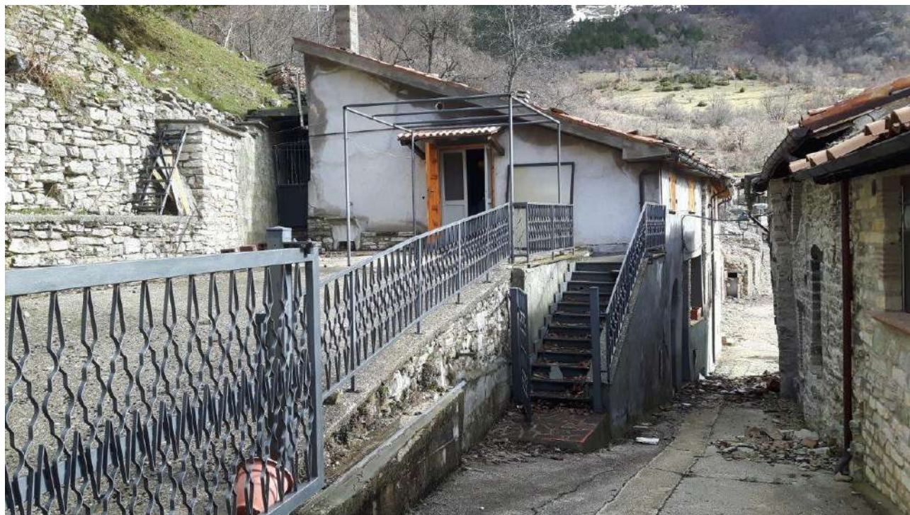
1. Foto stato di fatto Post Sisma ed Ante Demolizioni Frazione
