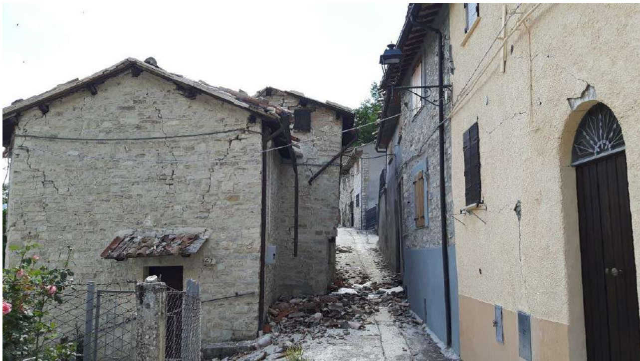
3. Foto stato di fatto Post Sisma ed Ante Demolizioni Frazione (Il Giunto strutturale di cui alle osservazioni era riferito appunto alla divisione tra il fabbricatola particella 41 e le altre aderenti 377-378-380 (di altro proprietario di colore giallo).
