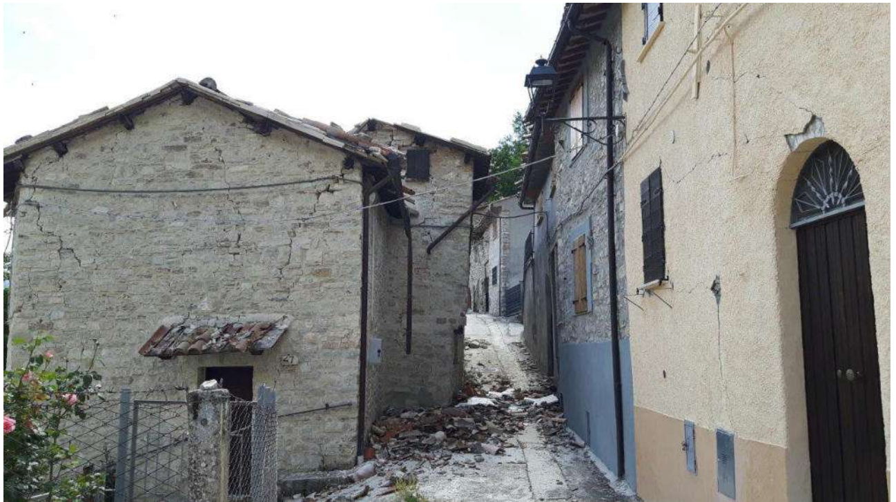
3. Foto stato di fatto Post Sisma ed Ante Demolizioni Frazione (Il Giunto strutturale di cui alle osservazioni era riferito appunto alla divisione tra il fabbricatola particella 41 e le altre aderenti 377-378-380 (di altro proprietario di colore giallo).
