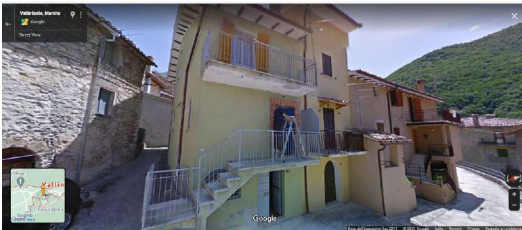
Immagine da Google maps – vista 1 da monte verso valle
